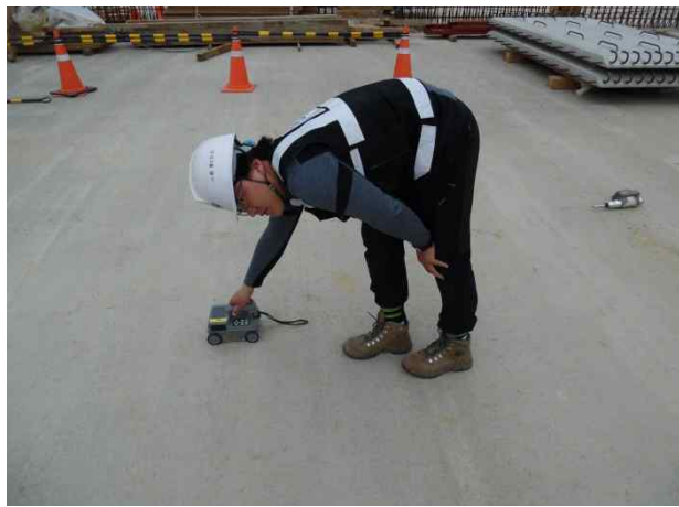
S9(상주방향) 슬래브 상면 철근배근탐사
