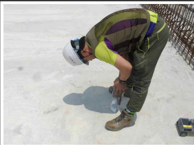
S2(상주방향) 슬래브 상면 반발경도시험
