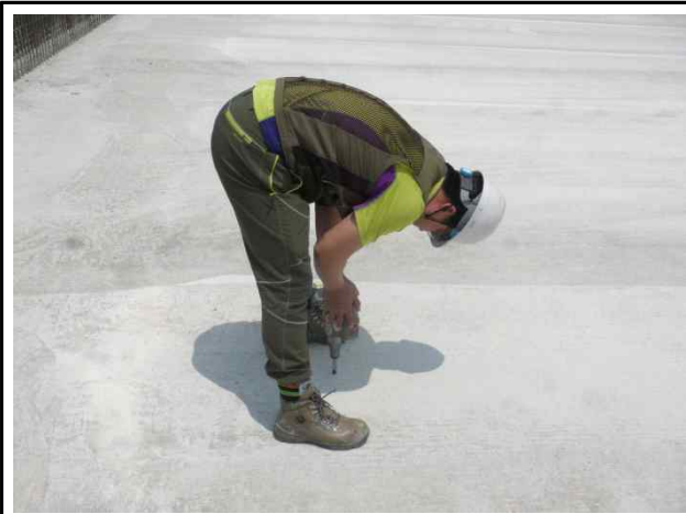
S1(상주방향) 슬래브 상면 반발경도시험
