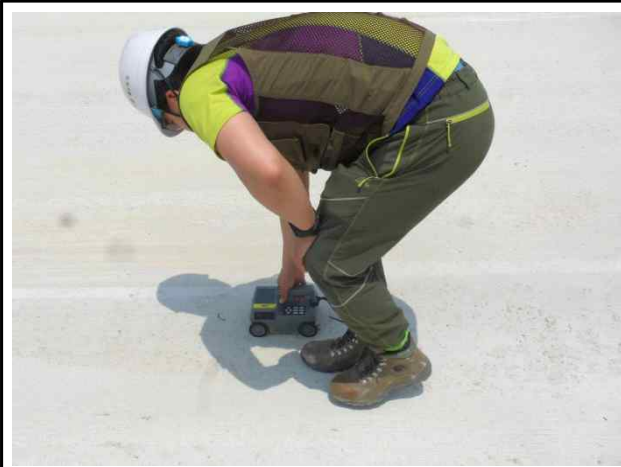
S2(상주방향) 슬래브 상면 철근배근탐사
