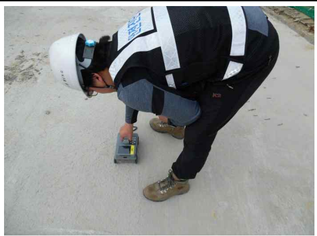
S8(상주방향) 슬래브 상면 철근배근탐사
