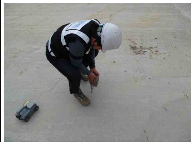
S8(상주방향) 슬래브 상면 반발경도시험
