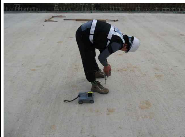
S10(상주방향) 슬래브 상면 반발경도시험
