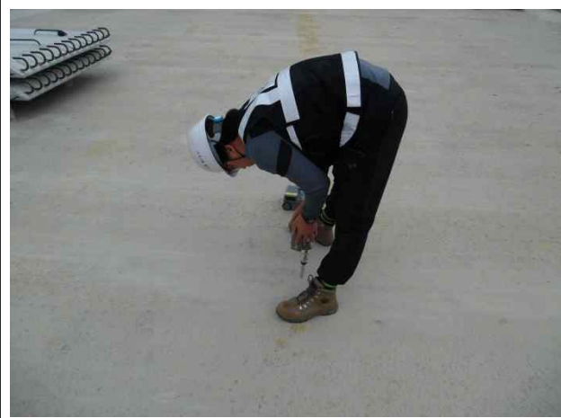
S9(상주방향) 슬래브 상면 반발경도시험
